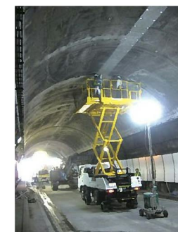
作業実績2 剥落防止シート施工
