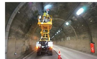
作業実績1 トンネル上部 コンクリート診断
